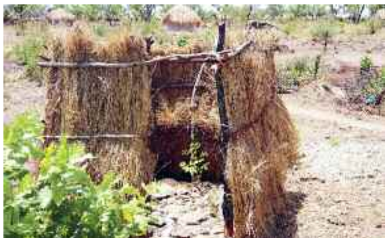
Una capanna in costruzione nel campo profughi di Rhino Camp
