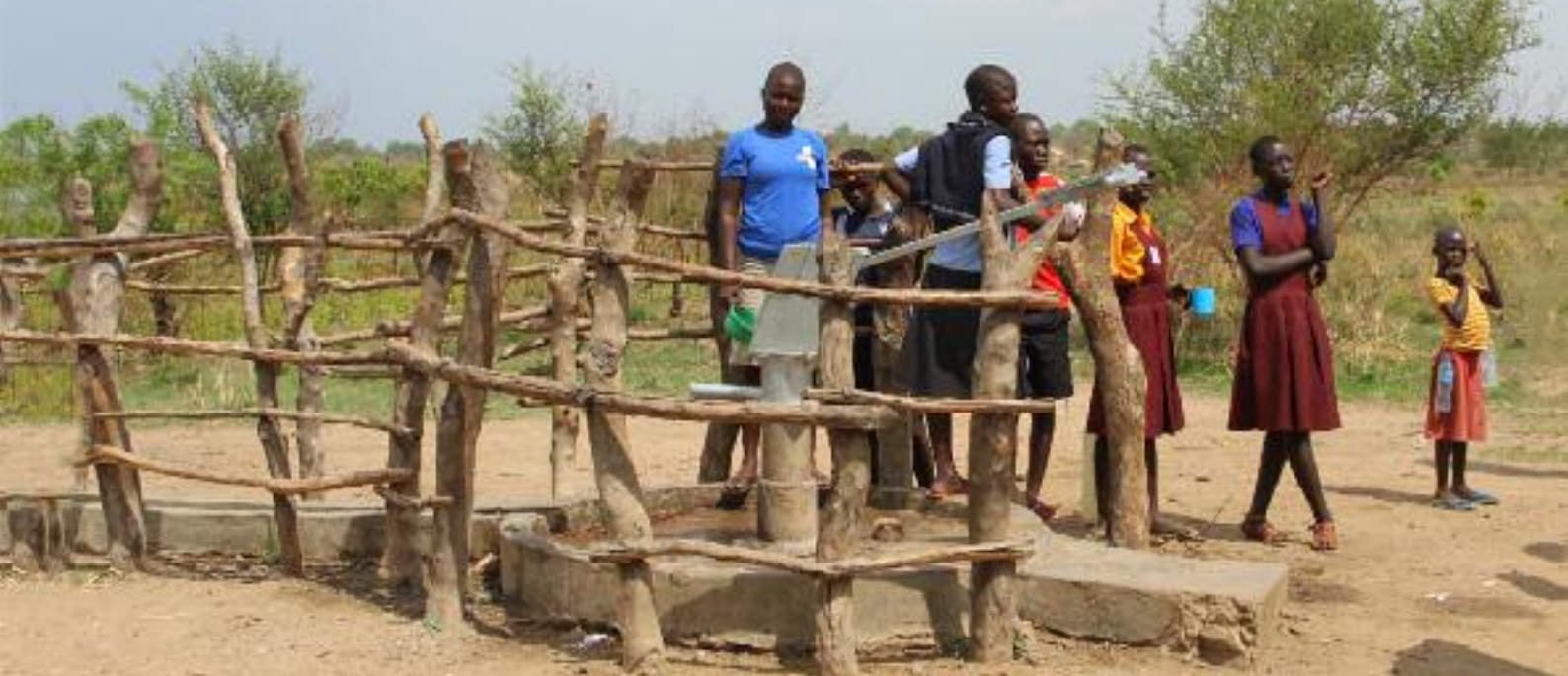
Uno dei pozzi perforati da ACAV nel campo profughi.
